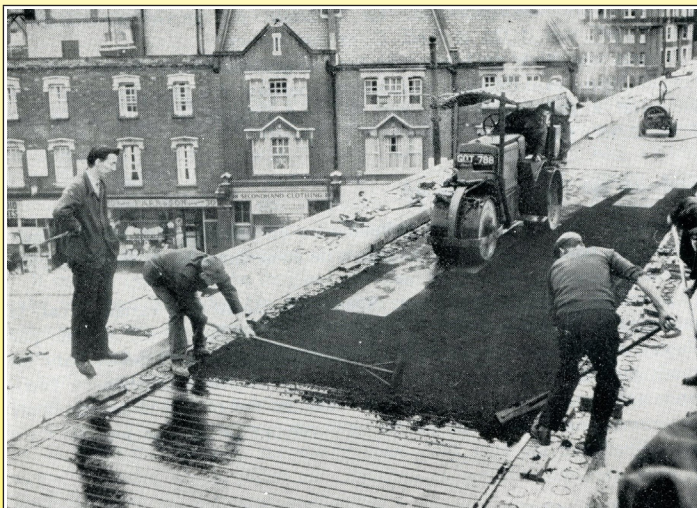
1969年在伦敦哈默施密特交叉路口的上面的行车道上铺设沥青。 (道路的电供暖由罗伯特·费利克斯提供，1971年，Ultimheat博物馆*)
