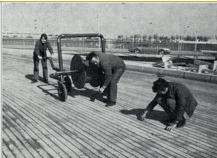
1968年，在巴黎附近的奥利机场的公共汽车停车平台的入口坡道上安装了供热网 (电的地板采暖，由罗伯特·费利克斯提供，1971年，Ultimheat博物馆*)
